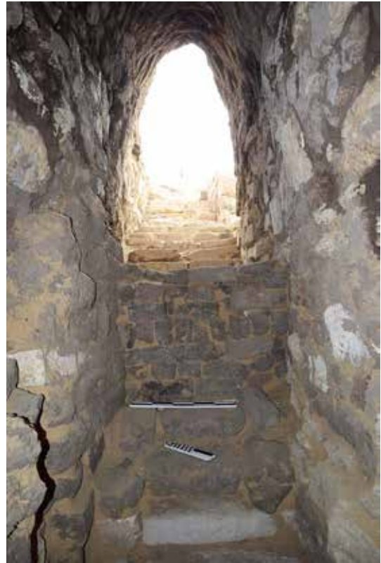
写真11 通廊内部（西より） Pl.11 The staircase inside the vaulted structure, viewing from the west
